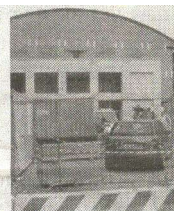
Lavori al Politeama
